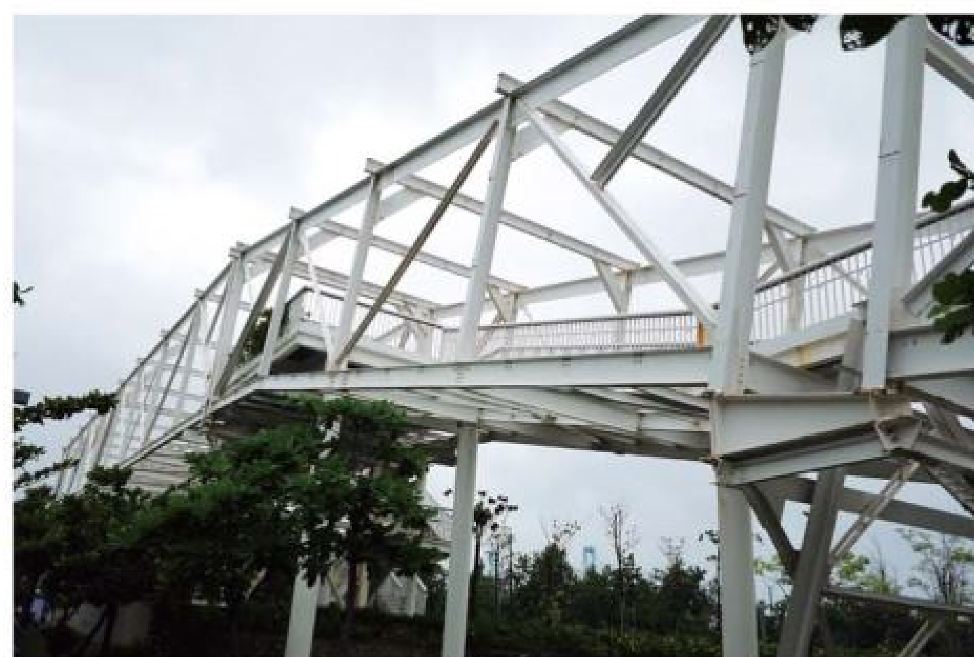
▲園區內設有天空步道，視野無限，可以一望無際港口進出船隻及園區空間。
