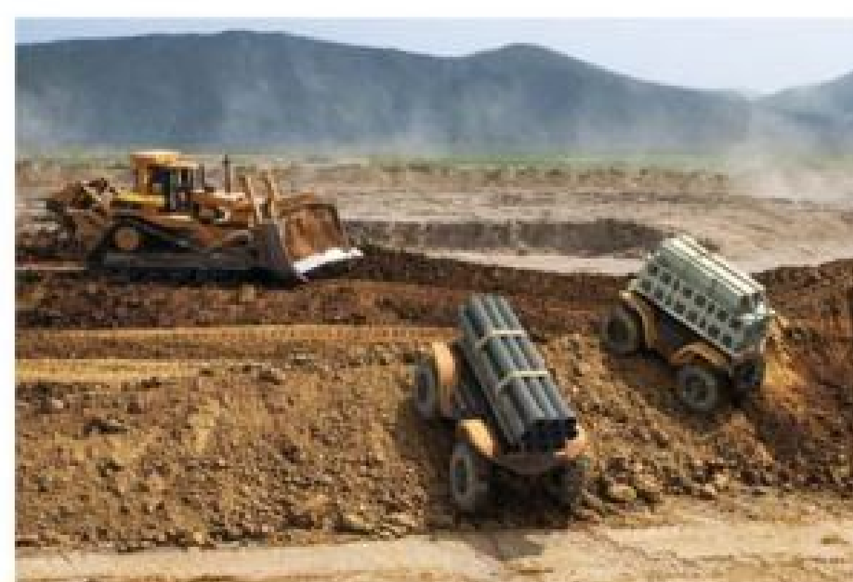
▲ 在工地進行建材載運。
